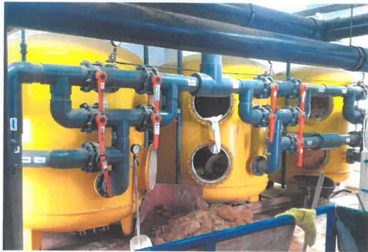
IV-4. ábra Homokszűrő tartályok szűrőhomok cseréje közben
